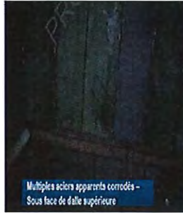
Eclat avec aciers apparents corrodés - Sous face de dalle supérieure
