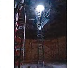
Accès central et plateforme non sécurisée
