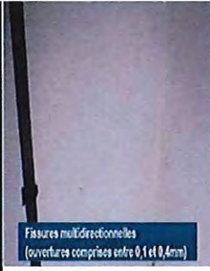
Eclat et fissuration - Couronnement extérieur
