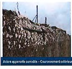
Multiple éclats avec aciers apparents corrodés -chambre des vannes
