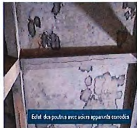
Intrusion d'eau par la toiture
