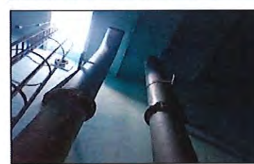
Aciers apparents corrodés - Couronnement extérieur
