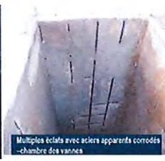
Corrosion avec perforations localisées - Voile intérieur
