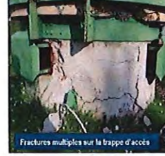
Eclats de béton avec aciers apparents corrodés généralisés
