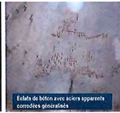
aciers apparents corrodés en sous face de dalle
