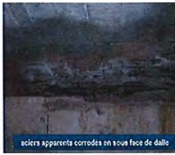
Eclats de béton avec aciers apparents corrodés généralisés
