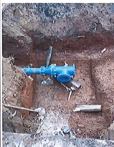
Montage de pièce au droit du regard Valcro
