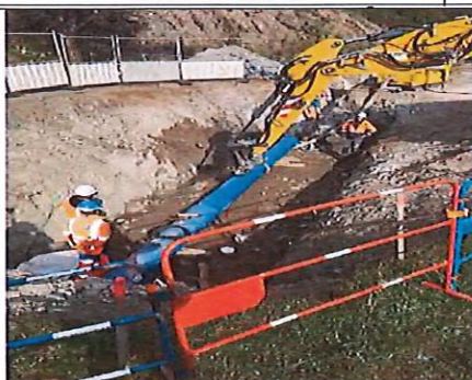
Sortie ø250 Fonçage 1
