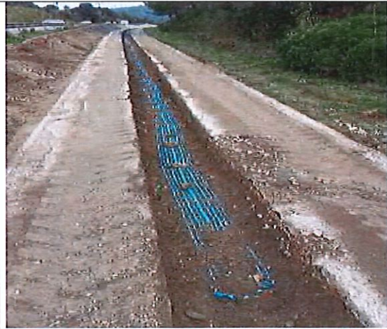
Remblaiement en réemploi à -30cm avant l'enrobé.
