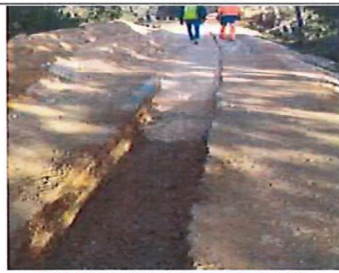
Remblaiement en cour sur Piste Cyclable
