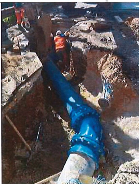
Raccordement côté Maravenna Terminé
