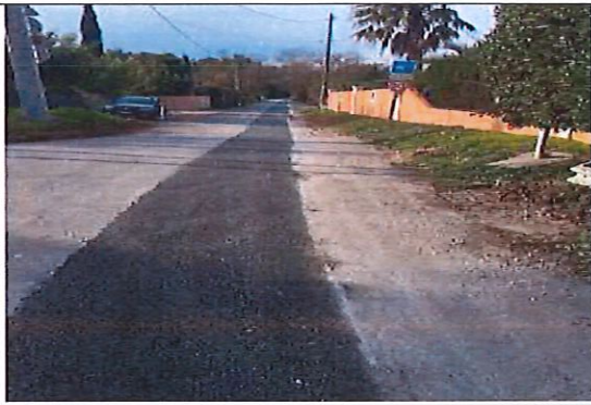
Remblaiement en réemploi à -30cm avant l'enrobé.
