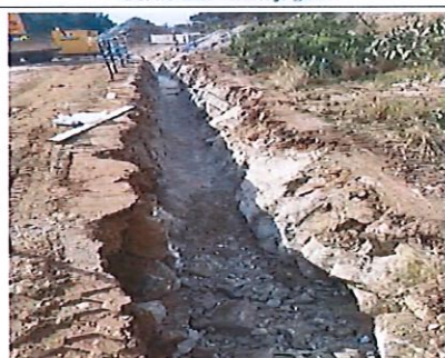
Tranchée après fonçage 2 vers col du trapan (Roche présente)
