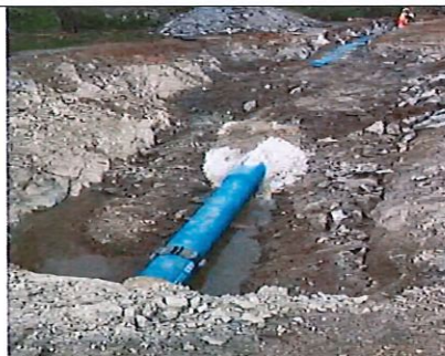
Remblaiement de la canalisation sortie fonçage 2 coté Trapan (enrobage grain de riz)
