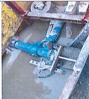
Montage des pièces fonçage 1 reste à mettre en place la vidange et le regard
