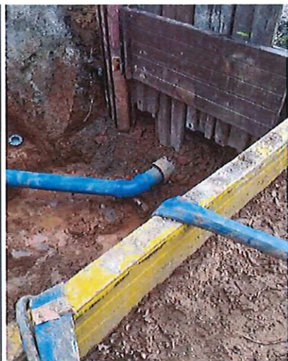
Sortie ø250 Fonçage 1
