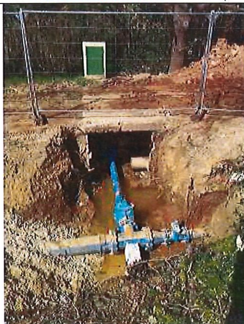
Raccordement Valcro Terminé
