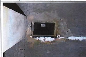
Epanchement de calcaire au droit de la cheminée d'aération
