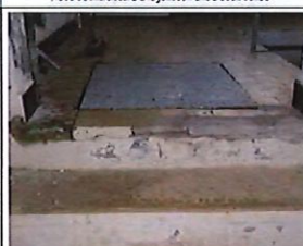
Éclatement de l'encadrement de la trémie d'accès à la zone entre les 2 baches d'eau traitée
