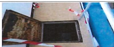
Vue rapprochée d'une trappe d'accès au couloir d'eau filtrée
