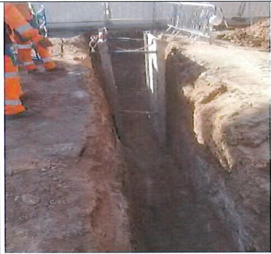
Puits de sortie du fonçage
