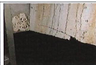
Cassure du béton au droit de la trémie d'accès à la cuve
