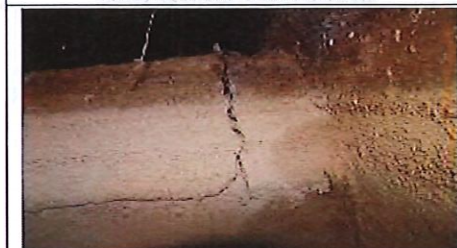
Fissuration traversante sur un coffret de vidange
