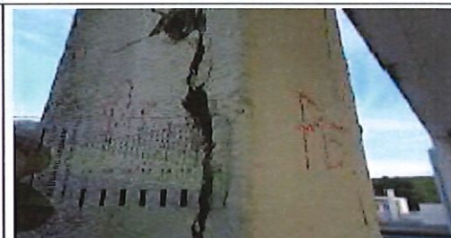
Fissures/lézarde visibles sur les poteaux soutenant la dalle de couverture en R+1 témoignant d'un défaut de capacité portante des poteaux ou d'un éclatement par corrosion des armatures
