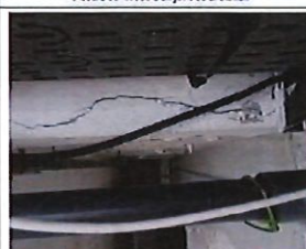
Éclatement de la poutre en intrados de couverture
