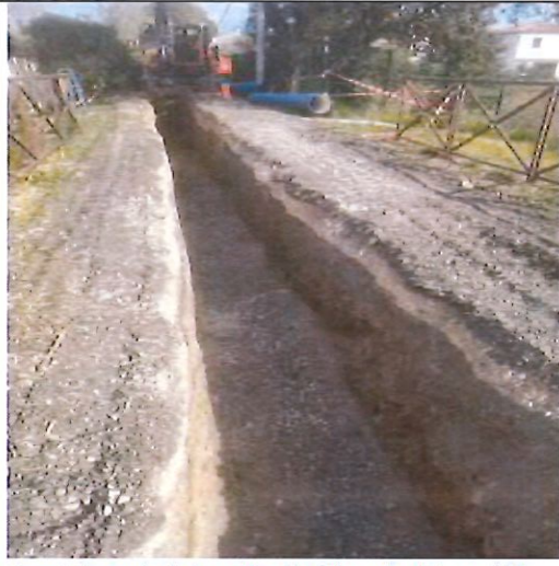
Tranchée au droit du cadre pluvial sur la piste cyclable en conservant une hauteur de couverture sur le cadre et son étanchéité de 20cm
