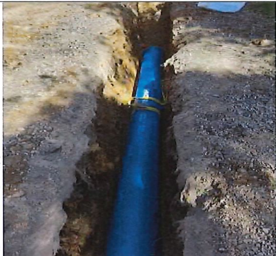
Mise en place cana sur piste cyclable
