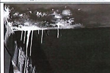
Stalactites de calcaire en intrados de poutrelle
