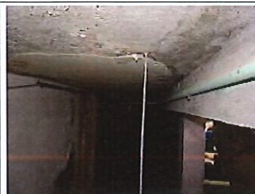
Dégradation de l'intrados du plancher du couloir amont des cases de pré-ozonation avec présence de fissures et infiltrations d'eau
