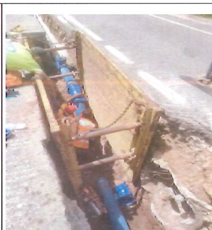
Mise en place d'une baïonnette pour passer sous les traversées pluviales.
