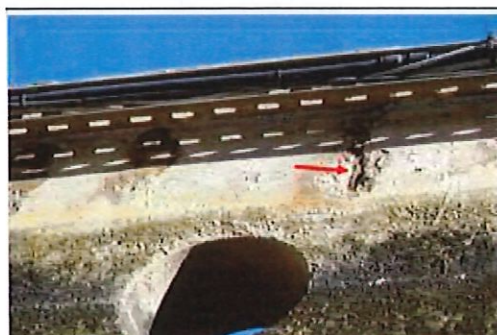
Armature apparente corrodée en partie supérieure du voile alvéolé
