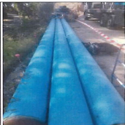
Tuyau acier pour encorbellement 12ml
