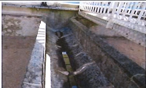
Fissuration avec épanchements de calcaire
