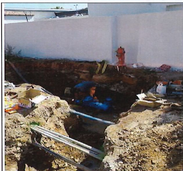
Raccordement du poteau incendie, vanne 200
