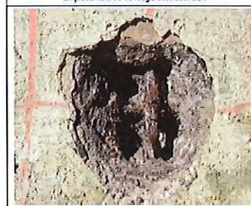
Vue rapprochée du sondage destructif SD1
