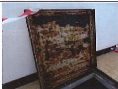
Corrosion générale des trémies d'accès
