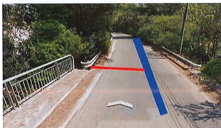
Vu avec le MOA et le MOE la vidange en rouge devra sortir dans le talus sous la glissière.
