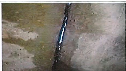
Jour au niveau des reprises de bétonnage
