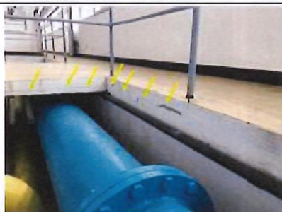
Fissures en extérieur de canal
