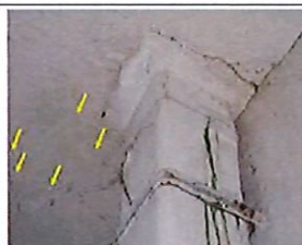
Fissures à la jonction poteau/dalle de couverture
