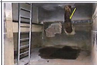
Corrosion de la canalisation d'alimentation de la tour d'ozonation
