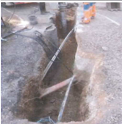
Départ de la piste cyclable coté RD559A Passage sous ENEDIS, TELECOM et GAZ
