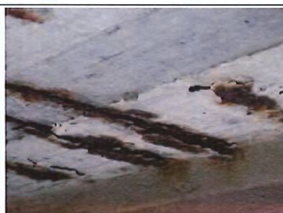
Vue détaillée des épaufrures avec armatures apparentes corrodées
