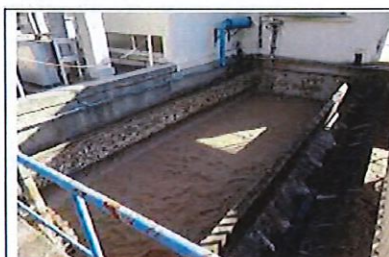
Vue d'ensemble d'un filtre à sable
