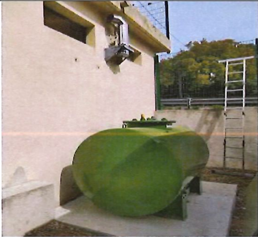
Cuve sur dalle et échappement du GE
