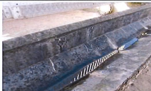
Fissuration avec épanchements de calcaire
