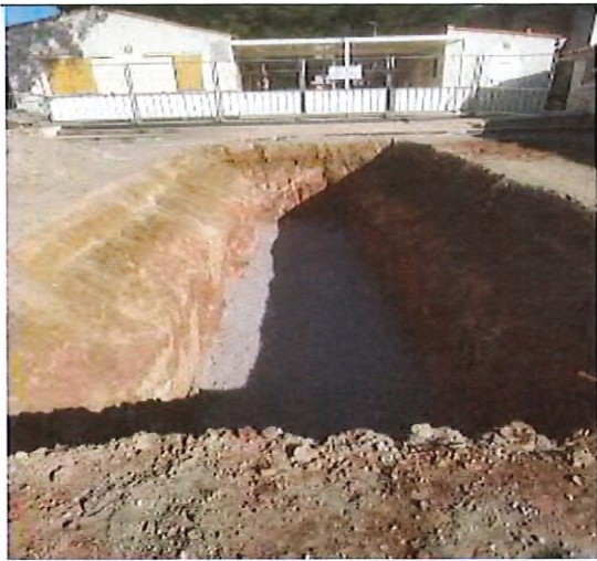
Puits d'entrée du fonçage
