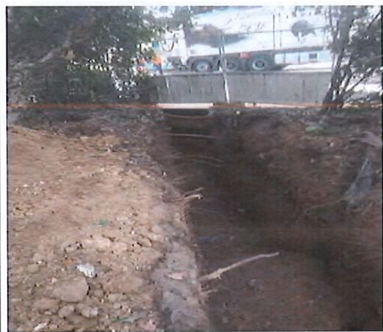
Passage sous pluvial, AEP, ENEDIS coté boulodrome sous RD559A
