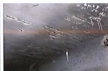
Armatures apparentes corrodées en intrados de couverture
