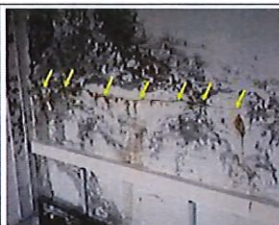
Fissure horizontale probablement traversante sur le voile séparatif avec les fibres à sable
