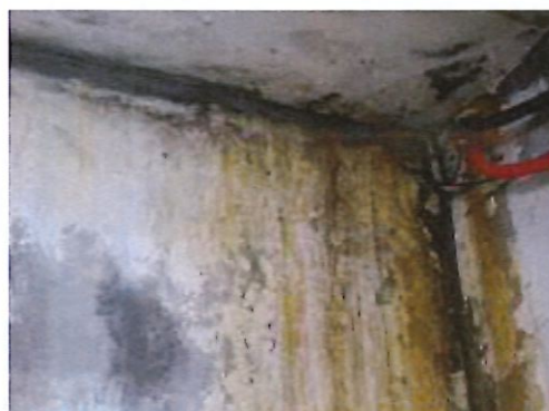
Infiltration / Traces de moisissures à la jonction voûte -couverture
