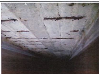
Épaufrures avec armatures apparentes corrodées
