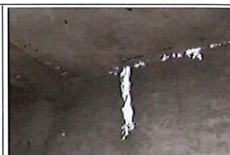
Epanchement de calotte au droit de l'intrados de couverture
