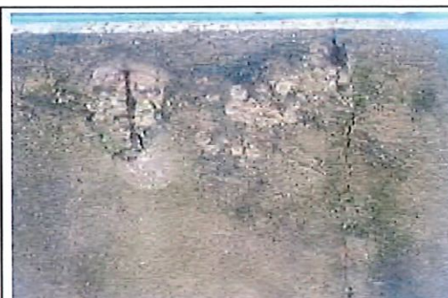
Armatures adossées corrodées en sous face de passerelle
