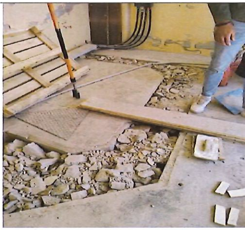
Comblement de la tranchée avec les gravats du chantier avant béton de propreté
