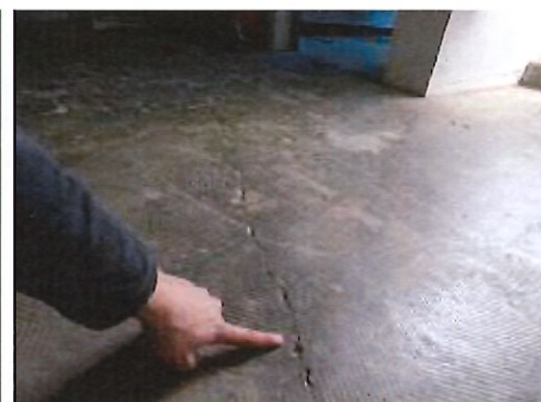
Fissure sur le plancher inférieur
