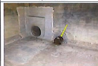
Corrosion avancée d'une traversée de paroi
