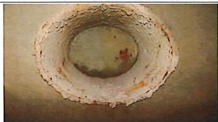
Corrosion des traversées de paroi et vannes
