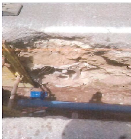
Buse abandonné dans le futur projet Mairie, une reprise temporaire sera effectuée afin de conserver son fonctionnement.
