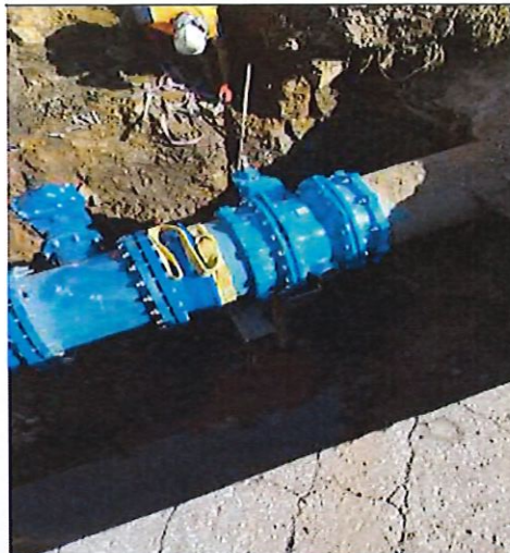
Canalisation 500, vanne 500, vanne 200 et fer d'ancrage
