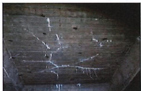
Vue d'un spectre d'armatures en intrados de couverture ainsi que des fissures multi-directionnelles avec épanchement de calcaire
