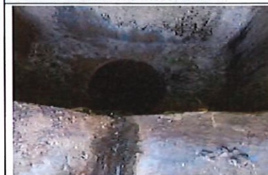
Canalisation de vidange des eaux de lavage
