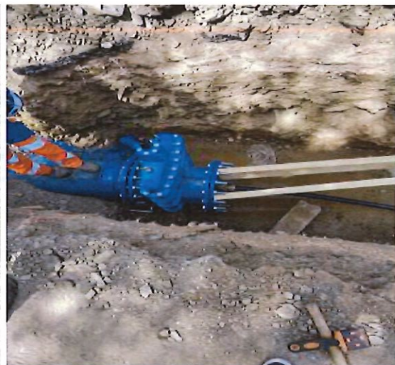
Mise en place cana a la fin de la piste cyclable au droit de la route du Caroubier
