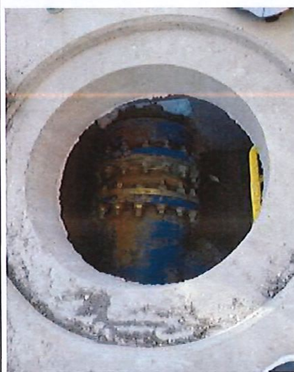
Canalisation 500, vanne 500, vanne 200 et fer d'ancrage
