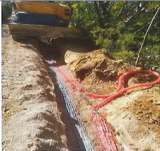
Canalisation 400 + fourreau \varnothing 63 y/c cablette dans enrobage
