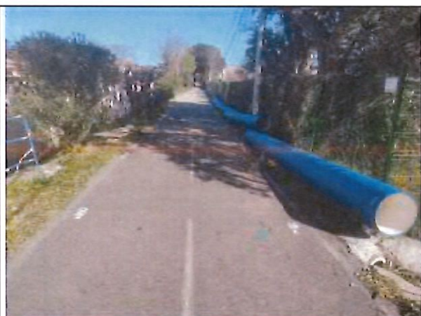
Bardage des tuyaux sur piste cyclable
