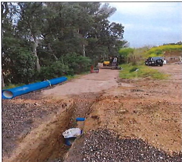
Mise en place cana au fin de la piste cyclable au droit de la route du Caroubier
