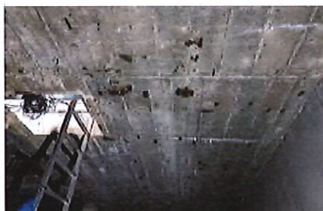
Armatures apparentes corrodées en intrados de couverture
