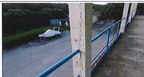
Fissure verticale sur un poteau
