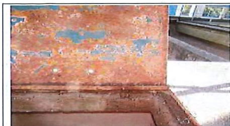
Corrosion généralisée des trémies d'accès
