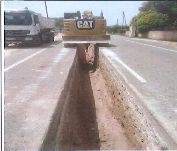
Utilisation BRH du a la sur profondeur environ 2.30m.
