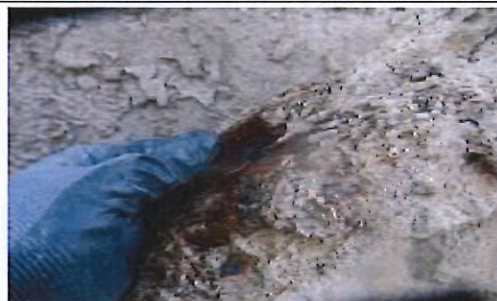
Corrosion des vannes canal eau décantée / filtres à sable
