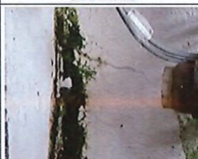
Trace de moisissure à la jonction entre deux voiles
