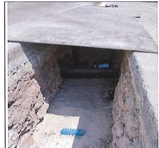
Busage conduite existante en attente de bétonnage. Cette traversée pluviale sera supprimée dans le projet Mairie.
