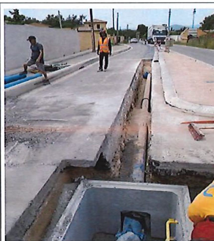
Busage conduite existante en attente de bétonnage. Cette traversée pluviale sera supprimée dans le projet Mairie.
