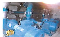
Pompes de relèvement d'eau brute
