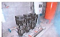
Suppresseurs d'eau de process
