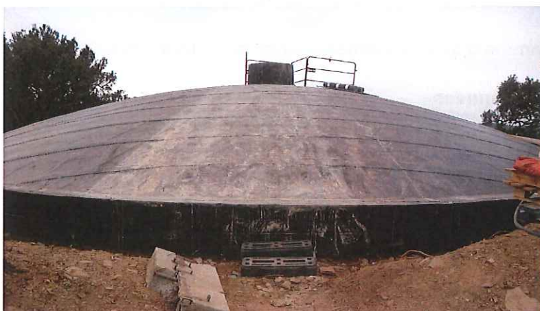
REHABILITATION DU PARTITEUR DE BORMES
