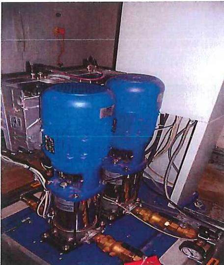
Le Nouveau suppresseur est installé dans un local situé dans l'enceinte de l'usine de traitement de CARNOULES Il a une capacité de 2 L/S. Sur le long terme , un suppresseur de capacité de 10 L/S sera ajouté dans le local de surpression
