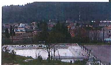
bassin de décantation des boues
